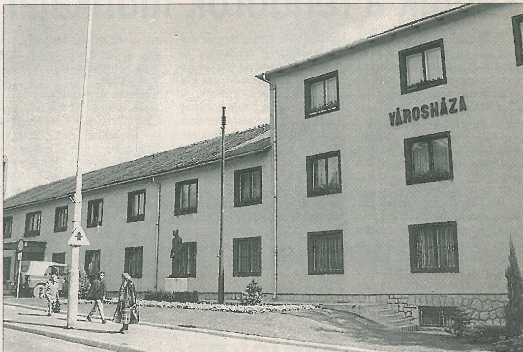
Az egykori „bányatröszt” épületéből kialakított polgármesteri hivatal tetőtérben kívánják elhelyezni a reprezentatív termet
