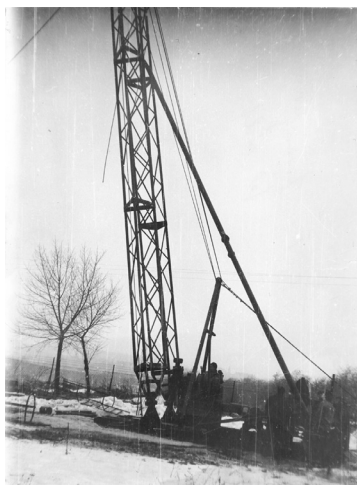
TA-13 tip. torony felállítása tanudvari feladat
