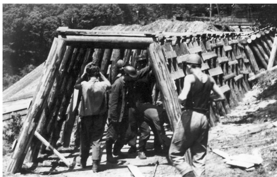
Komlói Tanbánya – Kővestető. Irányba ácsolás
